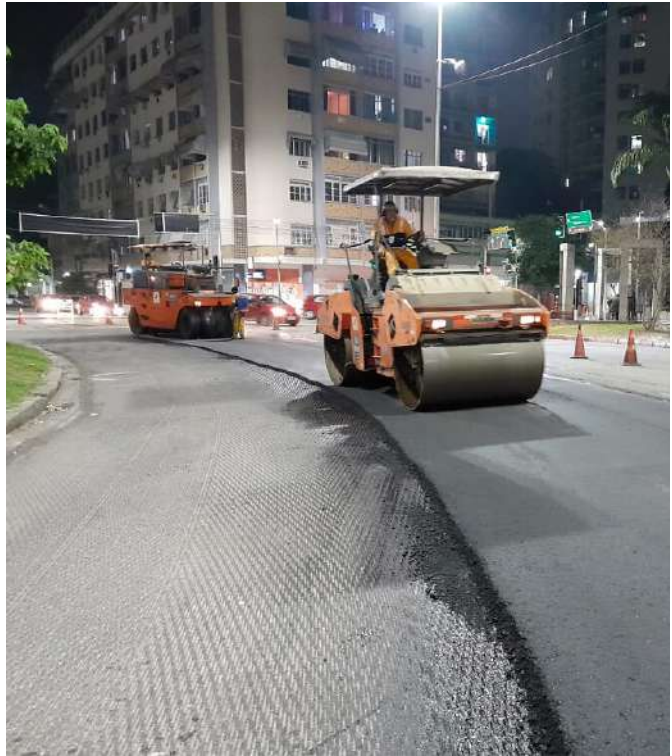
Figura 23. Substituição do pavimento no Boulevard 28 de Setembro
