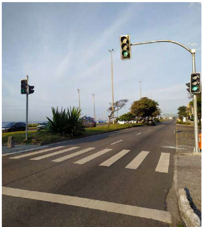
Figura 22. Novo semáforo instalado na orla
