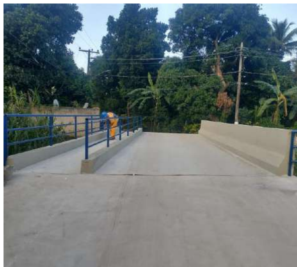
Figura 25. Ponte sobre o Rio Guandu do Sena, em Campo Grande.
