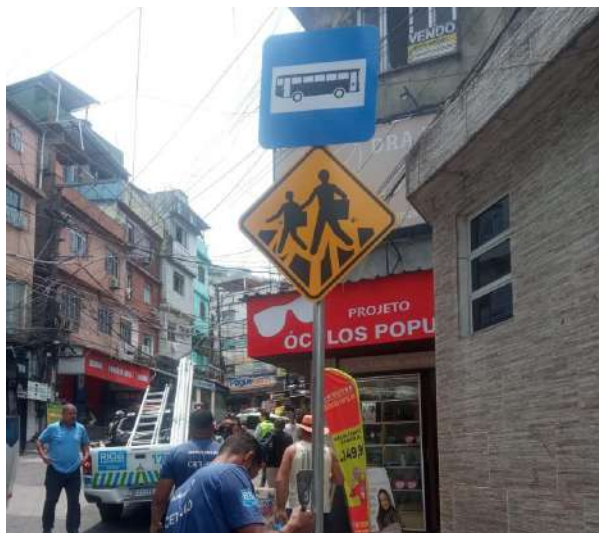
Figura 32. Nova sinalização vertical na Estrada da Gávea (Rocinha).
