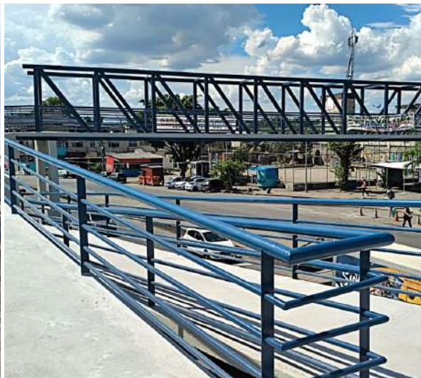
Figura 23. Prolongamento de passarela na Avenida Pastor Martin Luther King Júnior.
