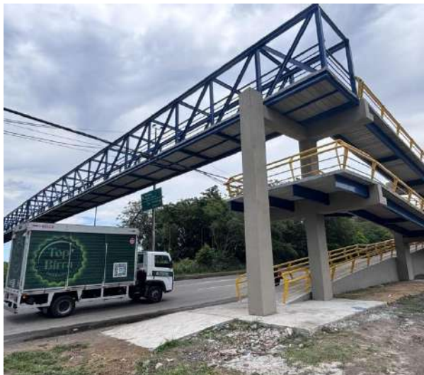
Figura 22. Nova passarela na Avenida Brasil, próximo à Estrada Aterrado do Leme.
